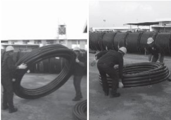
Con el sitio para desenrollar la tubería libre de objetos, tome uno de los rollos y ubíquelo en el suelo, con la punta hacia la parte inferior.
