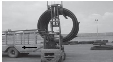
**3** Apoye los rollos en un lugar donde queden de forma vertical. Luego proceda conforme a la manipulación de rollos, para almacenarlos.
