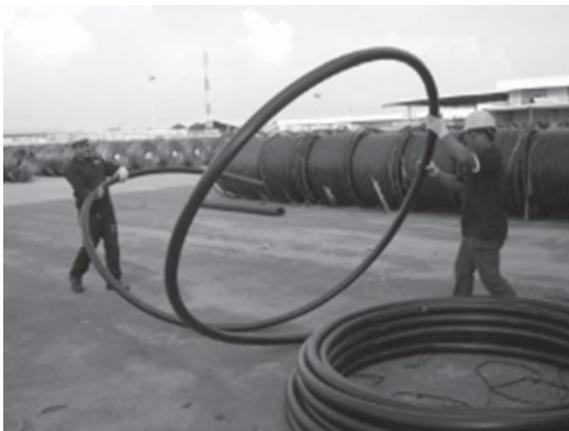
Comience jalando la punta de la bobina, a partir de la tubería de DN 63 mm se requiere de dos personas, uno que vaya jalando la punta y otro que vaya levantando las vueltas.
