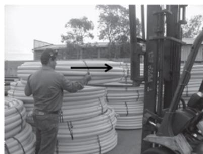
**2** Eleve el rollo y transportélo hasta aproximarse lo más cerca posible a la pila de tuberías, apóyelo y deslícelo hasta
